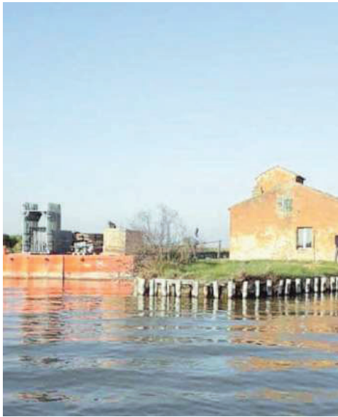
Lavori di arginatura nelle Valli di Comacchio (foto archivio)
