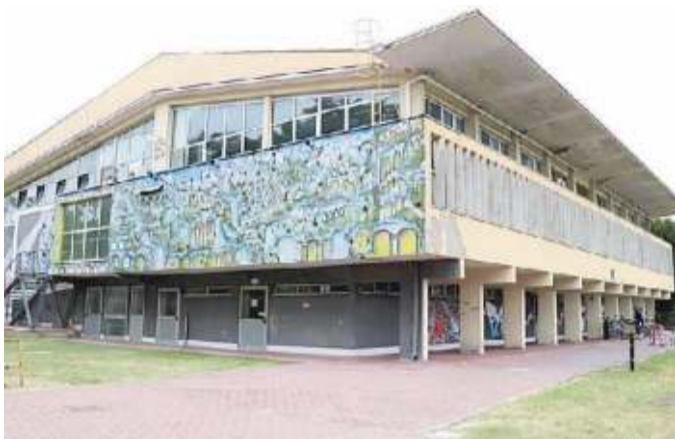
Il Palazzetto delle Palestre: il Comune intende comprarlo dal Coni
